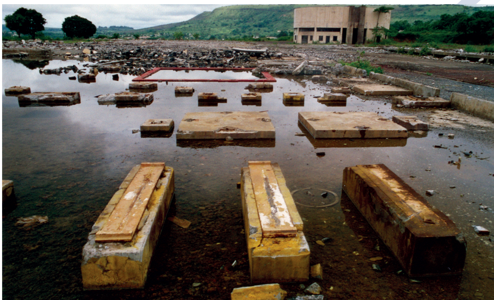
Überreste der Fabrik für die Herstellung von Urankonzentrat (Yellowcake) in Mounana. Ob die Sanierung des ehemaligen Betriebsgeländes fachgerecht durchgeführt wurde, ist fraglich.
