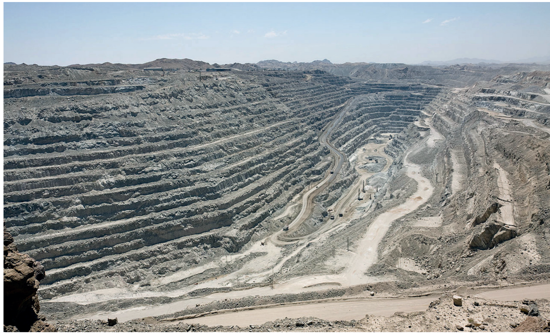
Der weltweit größte Urantagebau in Rössing, Namibia wurde 1976 in Betrieb genommen und wird von der internationalen Bergbaufirma Rio Tinto betrieben. Etwa zwei bis fünf Tonnen Roh-Erz müssen verarbeitet werden, um ein einziges Kilogramm Uranoxid herzustellen. Was übrig bleibt, wird als radioaktiver Abraum in der Nähe der Mine gelagert. Foto: Ikiwaner / GNU Free Documentation License
