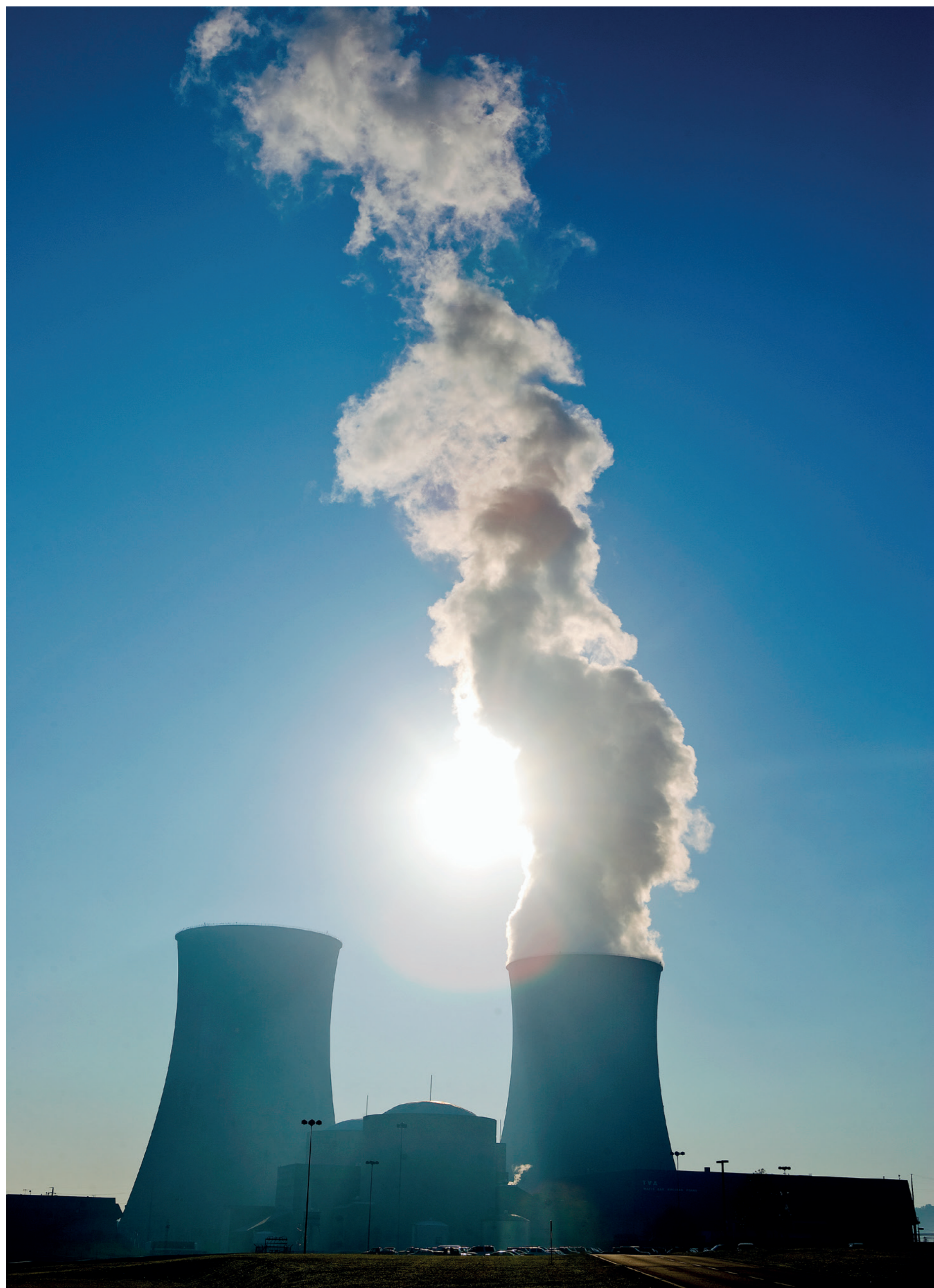
Das Atomkraftwerk Watts Bar am Tennessee River. In diesem „zivilen“ Atomkraftwerk wird neben Strom auch Tritium produziert, ein wichtiger Bestandteil von Atomwaffen. Dies ist nur eines von vielen Beispielen, wie zivile Atomkraftwerke genutzt werden, um Material für militärische Zwecke zu produzieren. Foto: TVA Web Team / creativecommons.org/licenses/by/2.0
